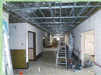
2階フロア改修中
